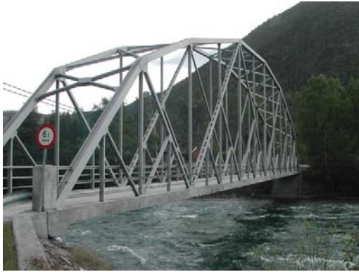
Figur 2.9 Fagverksbro i stål og stål og glass i moderne arkitektur Åsår bru over Sjøa (1937) og vernebygg Domkirkeodden Hamar (1998) (Foto JJJ).
