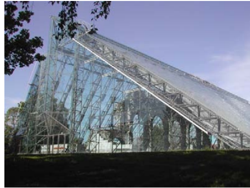
Figur 2.9 Fagverksbro i stål og stål og glass i moderne arkitektur Åsår bru over Sjøa (1937) og vernebygg Domkirkeodden Hamar (1998) (Foto JJJ).
